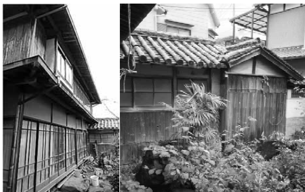
写真-1 建物外観 写真-2 水回り部分外観
