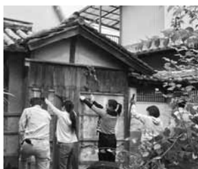
写真-3 板塀の張替え
