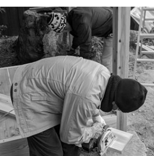
写真-8 デッキづくり
