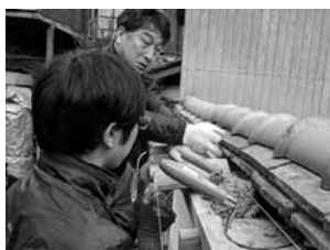
写真-6 塀の瓦の据直し
