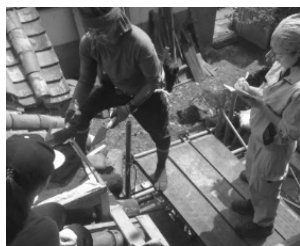
写真-4 屋根瓦の据直し
